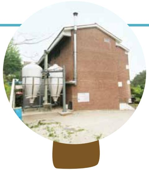
평택시무봉산청소년수련원(이하 수련원)은 1999년 무봉산 일대 13만 3천여㎡의 부지에 건립된 곳으로 생활관과 강당, 특별활동실, 야영장, 수영장, 눈썰매장, 극기훈련장, 운동장, 등산로 등 각종 수련시설을 갖추고 있는 곳입니다. 수련원에서는 최근 지속되는 고유가에 대한 대책으로 난방유를 대체할 방법을 찾던 중, 목재펠릿을 이용하는 대용량의 보일러도 개발되어 있음을 알게 되었다고 합니다. 이에 산림청 보급사업으로 목재펠릿보일러를 설치하여 지난겨울부터 61개 객실(712명 수용)의 난방과 온수공급용으로 사용하고 있습니다. 경우 사용 대비 절반에 달하는 비용 절감뿐만 아니라 이용객 만족도, 교육적인 효과 면에서 긍정적인 반응을 얻고 있는 만큼, 공공시설에 펠릿보일러를 도입하여 경제적·환경적·교육적 효과를 높이는 좋은 사례가 되고 있습니다.
